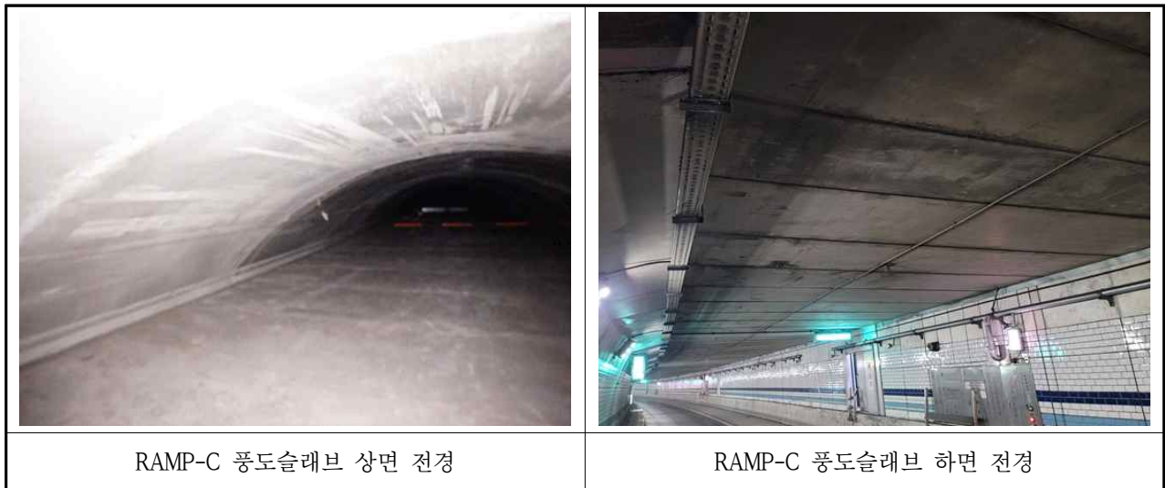
【사진 3.3.27】 NATM구간 풍도슬래브 전경
