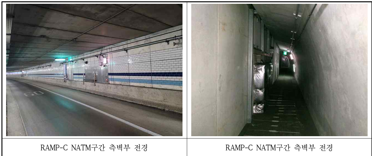
【사진 3.3.25】 NATM구간 측벽부 전경
