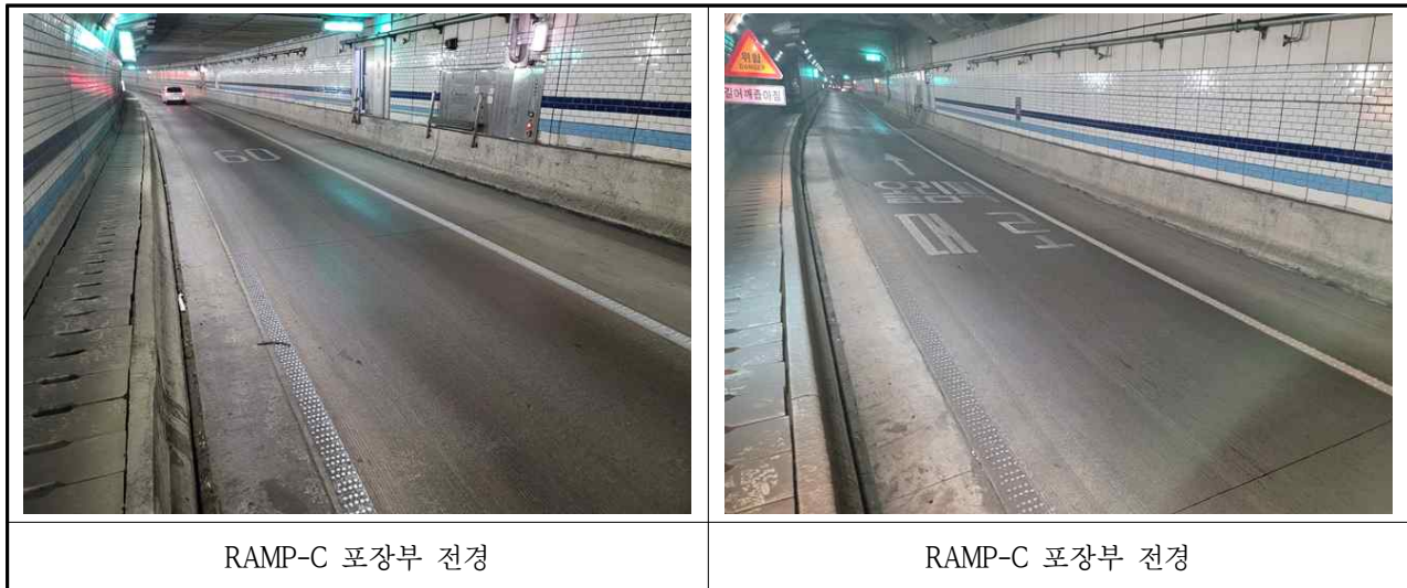
【사진 3.3.29】 포장부 전경
