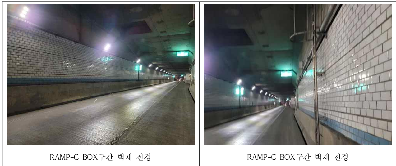
【사진 3.3.21】 BOX구간 벽체 전경
