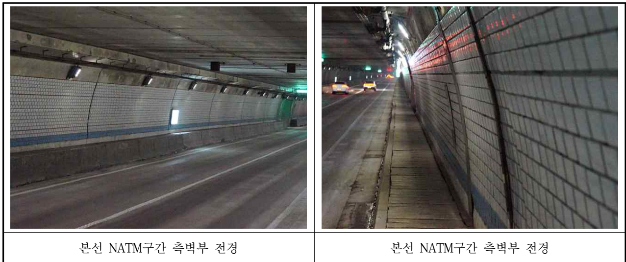
【사진 3.3.7】 NATM구간 측벽부 전경
